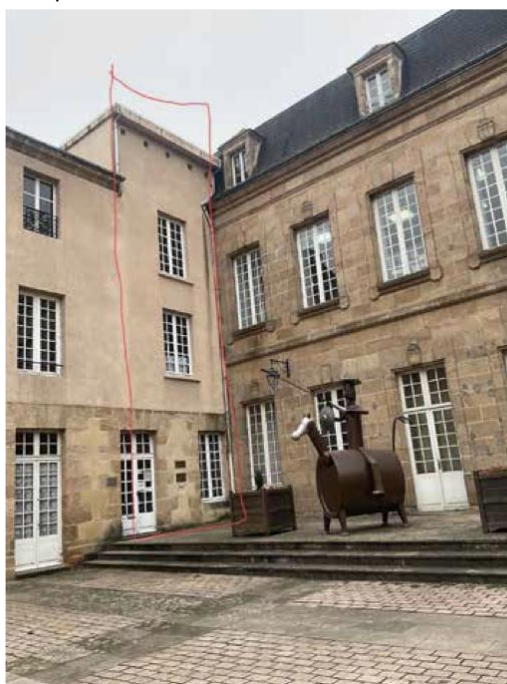
Hôtel de Villaines : jonction (entouré rouge) entre aile sud et corps principal
